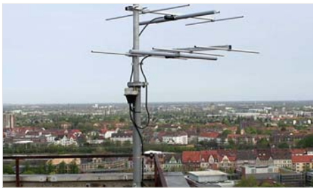
Antenne für DRM+ in Hannover
